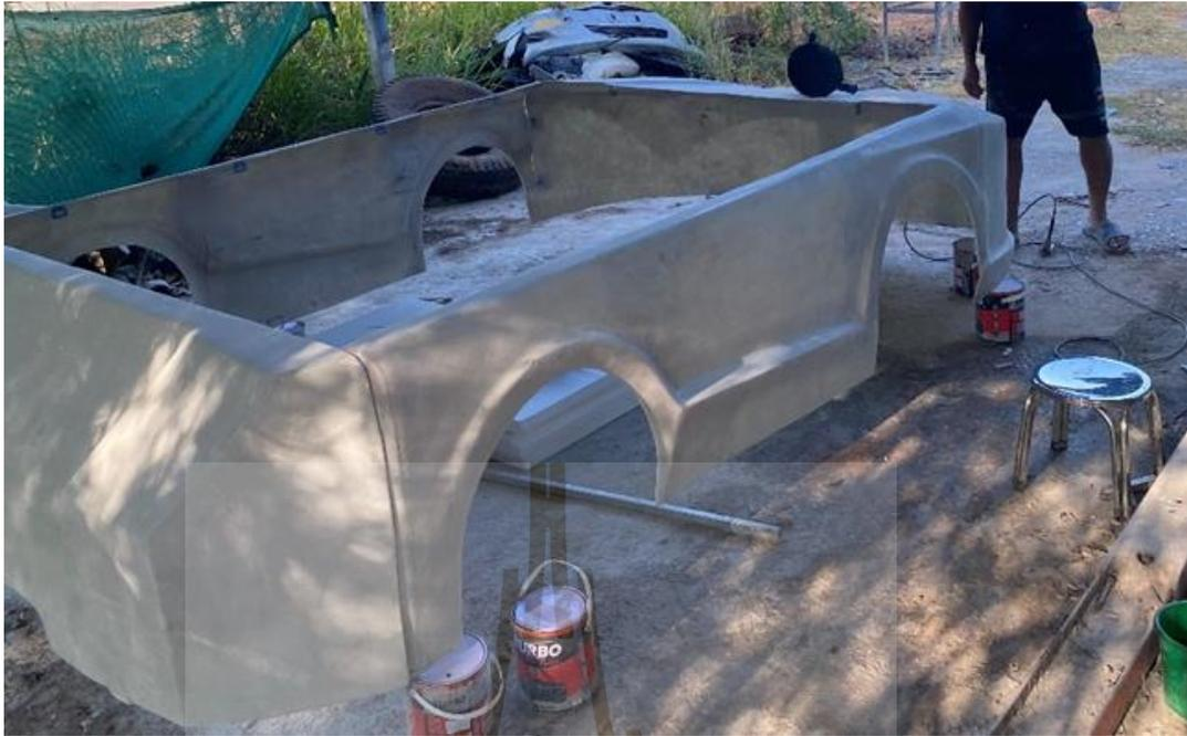
รูปที่ 5.10 การสร้าง Cover ของรถขนส่งอัตโนมัติ
