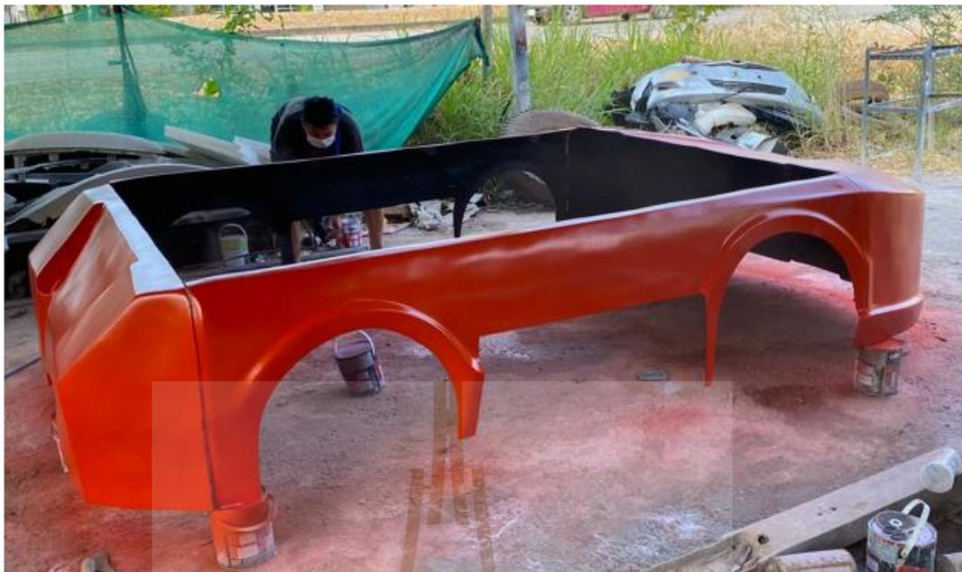
รูปที่ 5.12 การทำสีจริงตัว Cover ของรถขนส่งอัตโนมัติ
