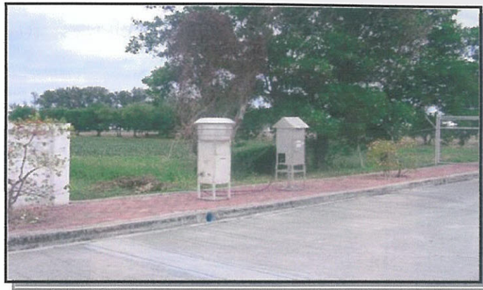
รูปที่ 2.17 : แสดงสถานีตรวจวัดคุณภาพอากาศภายในพื้นที่ทำอากาศยานภูเก็ต บริเวณก่อสร้างลานจอดอากาศยาน
