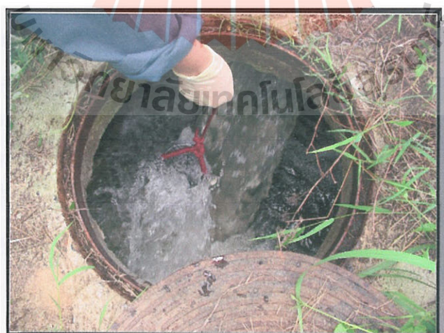
รูปที่ 2.21 : แสดงการเก็บตัวอย่างน้ำเสียก่อนเข้าระบบบำบัดน้ำเสีย
