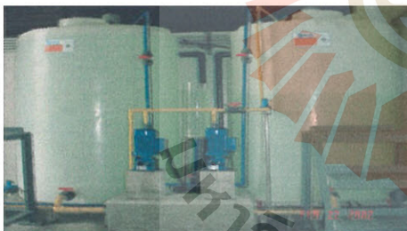
รูปที่ 2.14 แสดงระบบฆ่าเชื้อโรคด้วยคลอรีน
