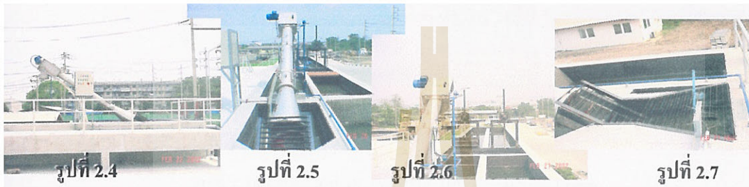
รูปที่ 2.4 – 2.7 แสดง ตะแกรงดักขยะอัตโนมัติ
