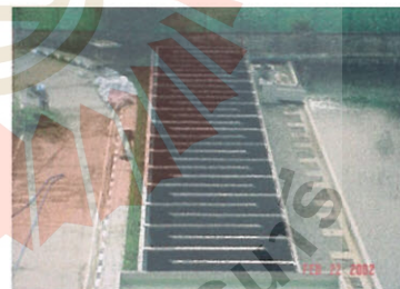
รูปที่ 2.15 แสดงถังสัมผัสคลอรีน
