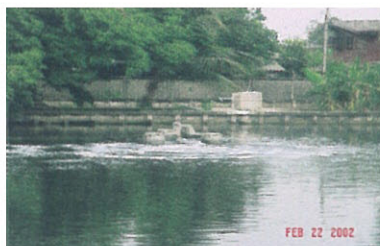
รูปที่ 2.16 แสดง Polishing Pond
