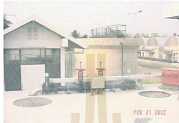
รูปที่ 2.10 แสดง Equalizing Tank และ Equalizing Pump
