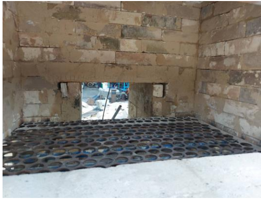
ก. รูปทรงและทางเดินลมร้อนจากการสร้างและทดสอบครั้งที่ 1
