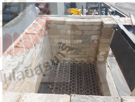
รูปที่ 4- 12 ผลการออกแบบและสร้างห้องเผาไหม้
