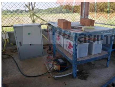
รูปที่ 18 ระบบการตามจุดกำลังสูงสุดของแผงโซลาเซลล์ขนาด 2,400 W ณ ฟาร์มมหาวิทยาลัย
