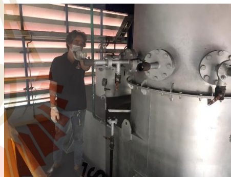
ข. เปิดวาล์วทางเข้าออกของอากาศรอบตัวเตา
