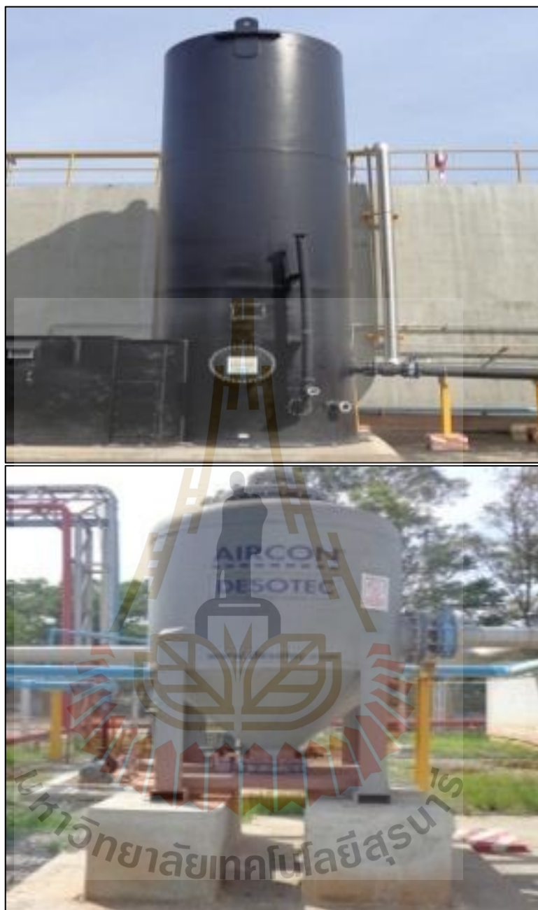
รูปที่ ก.5 ขั้นตอนระบบดักจับก๊าซไฮโดรเจนซัลไฟด์ โดย Wet Scrubber และ Carbon Filter
