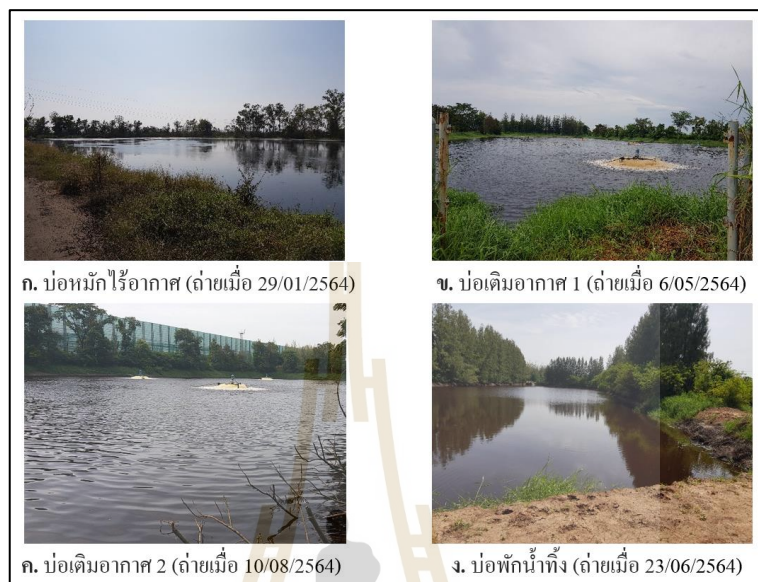
รูปที่ 4.8 ระบบบำบัดน้ำเสียแบบบ่อเติมอากาศ (Aerated lagoon)
