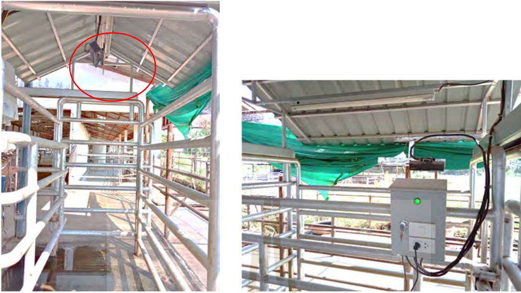
ภาพที่ 5.15 แสดงตำแหน่งการติดตั้งกล้อง Kinect และตู้ควบคุมระบบไฟฟ้าเข้ากับช่องบังคับโค
