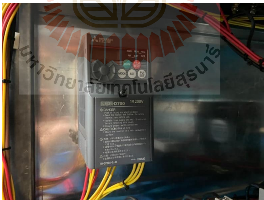
รูปที่ 3.16 Inverter Mitsubishi Model: FR-D720S-0.4K
