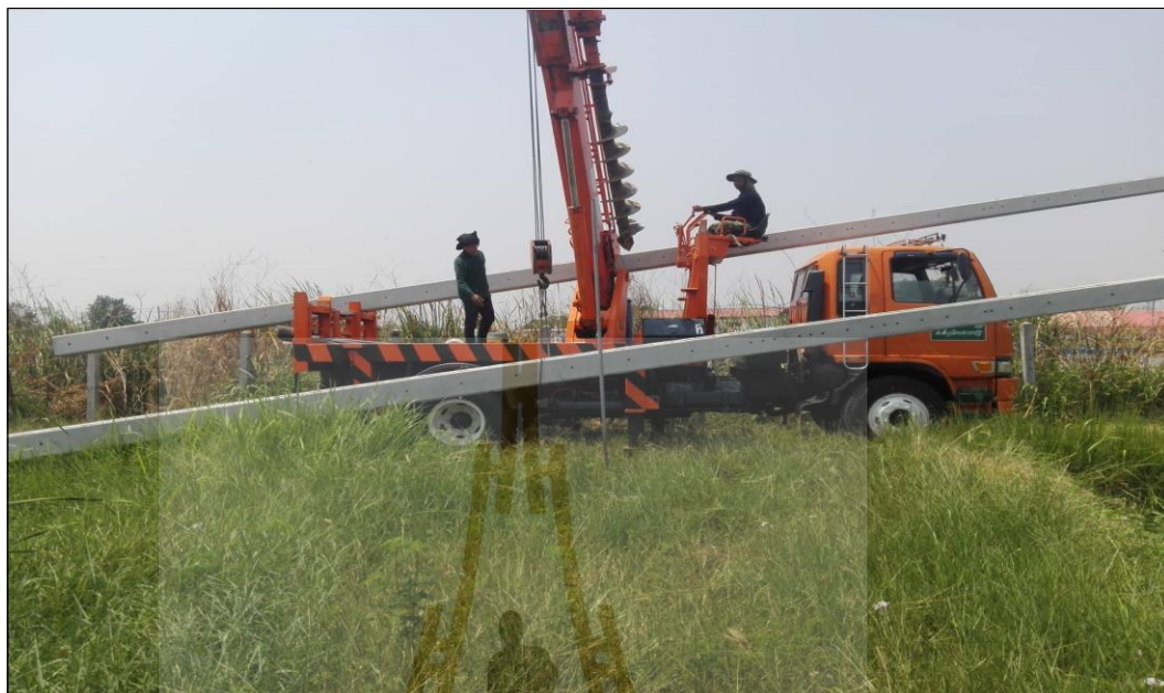
รูปที่ 3.12 ตั้งเสา
