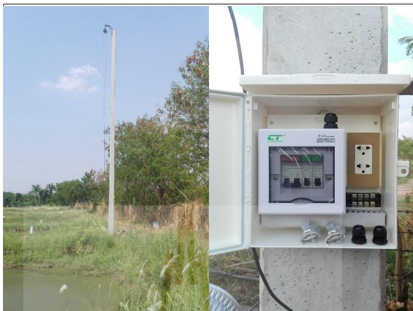
รูปที่ 3.14 ติดตั้งเบรคเกอร์สำหรับ Winch แต่ละตัว
