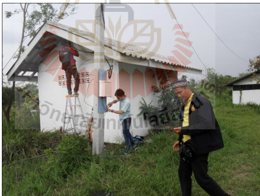
รูปที่ 3.15 ต่อไฟฟ้าเข้าระบบ
