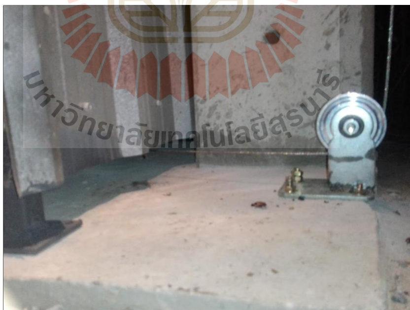
รูปที่ 3.18 ติดตั้งตัวนำ Cable
