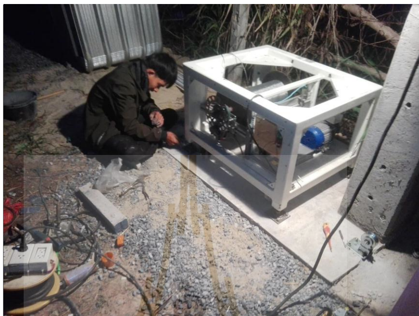
รูปที่ 3.16 ติดตั้ง Winch
