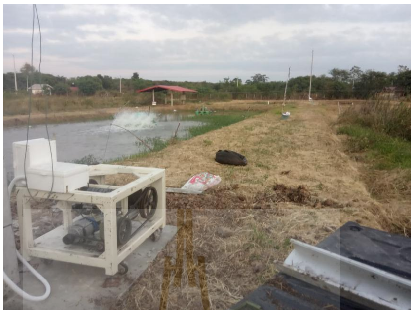
รูปที่ 3.18 ต่อไฟฟ้าให้ Winch
