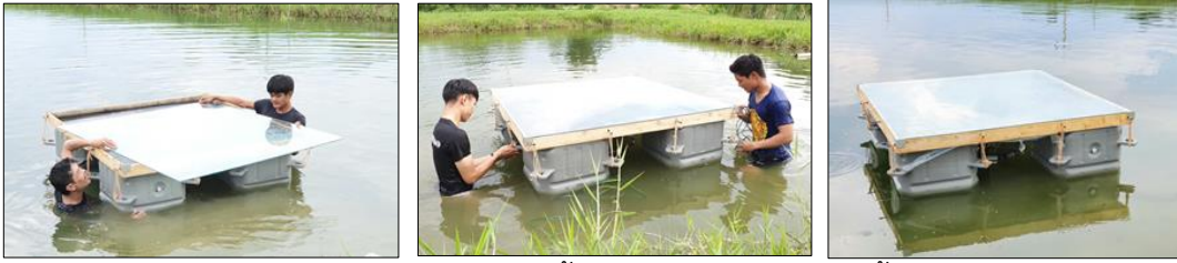
รูปที่ 3.24 การติดตั้งระบบเติมอากาศในบ่อเลี้ยง
