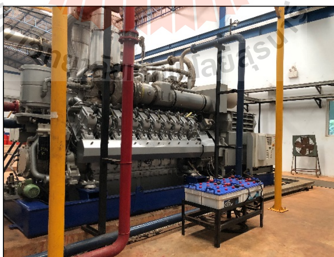
รูปที่ 2.4 เครื่องยนต์ผลิตไฟฟ้าจากก๊าซชีวภาพ
