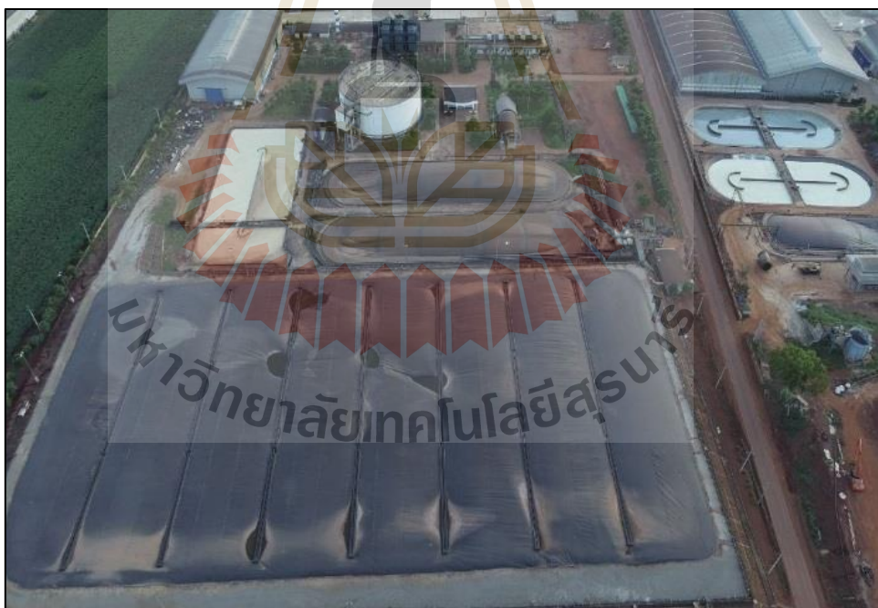
รูปที่ ค.4 กระบวนการหมักก๊าซชีวภาพ
