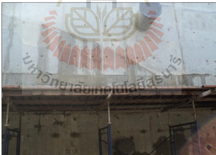
รูปที่ ก.6 ลักษณะน้ำรั่วซึมบ่อกรองละเอียด
