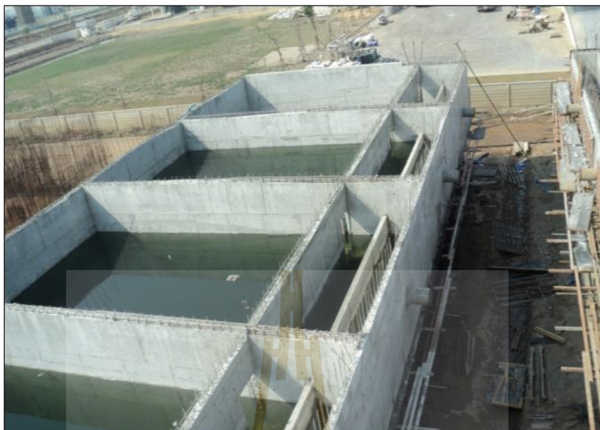
รูปที่ ก.5 เติมน้ำทดสอบบ่อกรองละเอียด
