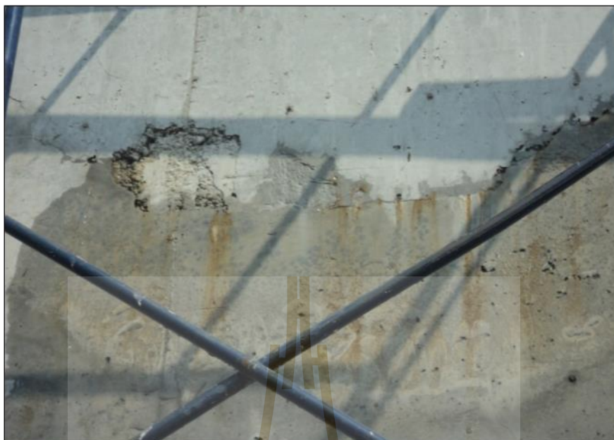
รูปที่ ก.7 ลักษณะน้ำรั่วซึมบ่อกรองละเอียด
