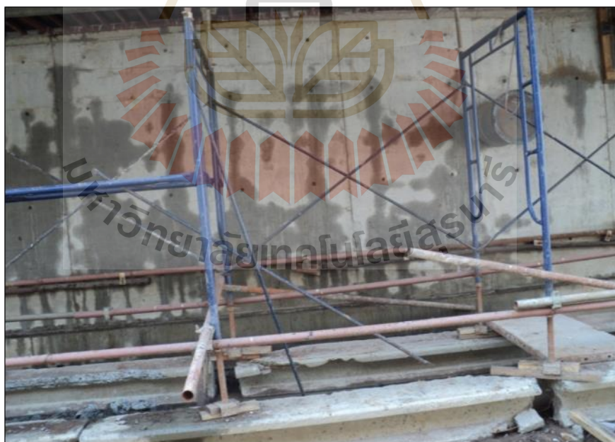
รูปที่ ก.12 ลักษณะน้ำรั่วซึมบ่อกรองละเอียด
