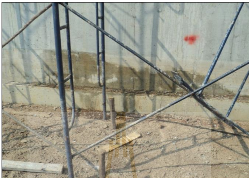
รูปที่ ก.9 ลักษณะน้ำรั่วซึมบ่อกรองละเอียด
