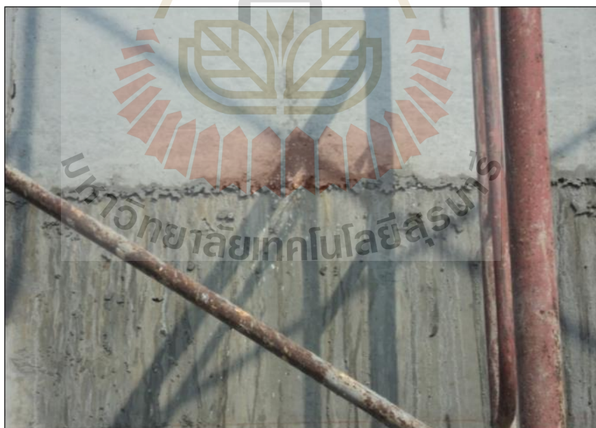
รูปที่ ก.8 ลักษณะน้ำรั่วซึมบ่อกรองละเอียด
