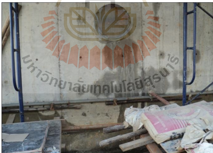
รูปที่ ก.10 ลักษณะน้ำรั่วซึมบ่อกรองละเอียด
