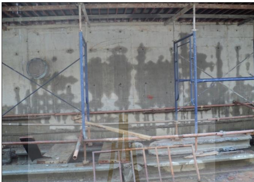
รูปที่ ก.11 ลักษณะน้ำรั่วซึมบ่อกรองละเอียด
