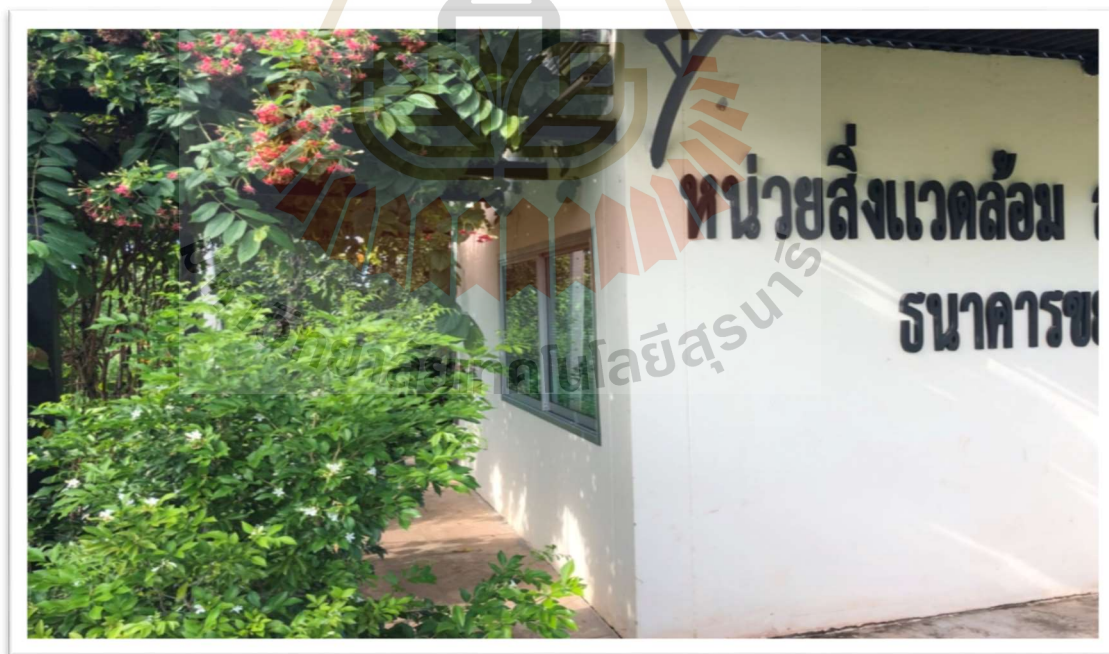
รูปที่ ก.6 รูปข้างอาคาร (ทิศตะวันตก) อาคารหน่วยสิ่งแวดล้อม
