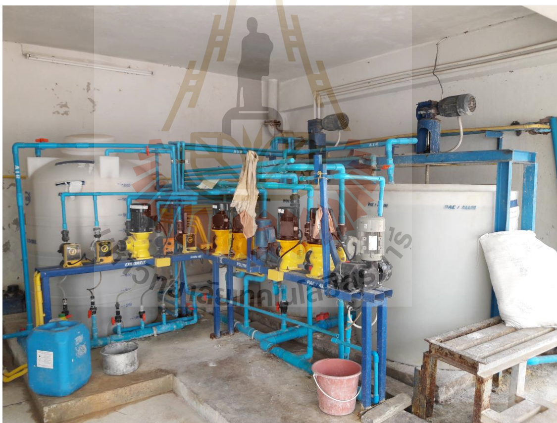
รูปที่ 4.9 ระบบหยดคลอรีน สารส้ม และโพลิเมอร์
