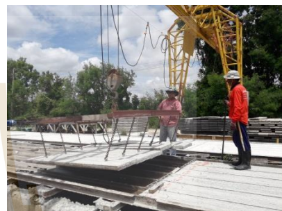
รูปที่ 4.2 การตัดลวดเหล็กและถอดแบบออกจากชิ้นงานของ Mix16 ที่ระยะบ่ม 1 วัน
