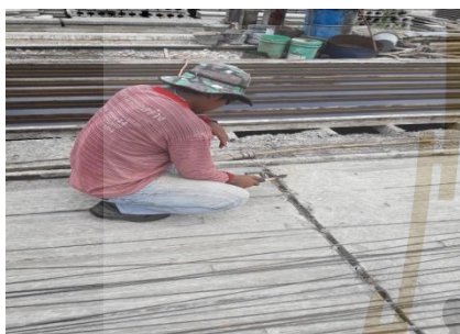
รูปที่ 4.2 การตัดลวดเหล็กและถอดแบบออกจากชิ้นงานของ Mix16 ที่ระยะบ่ม 1 วัน
