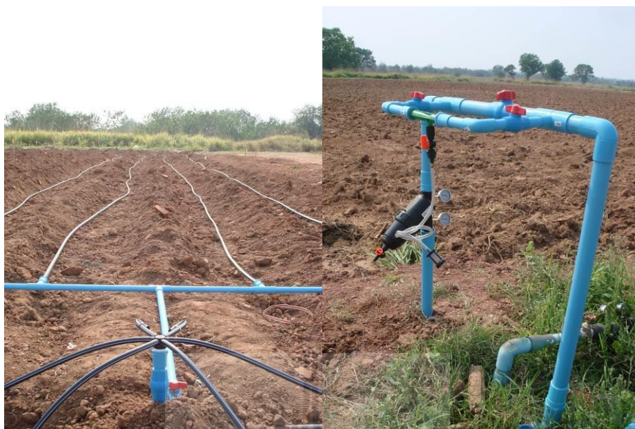
ภาพที่ 4 การวางระบบน้ำหยด และระบบปุ๋ยทางระบบน้ำ
