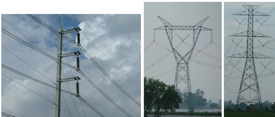
รูปที่ 3.27 การใช้ลูกถ้วยแขวนในระบบส่งจ่ายกำลังไฟฟ้า
