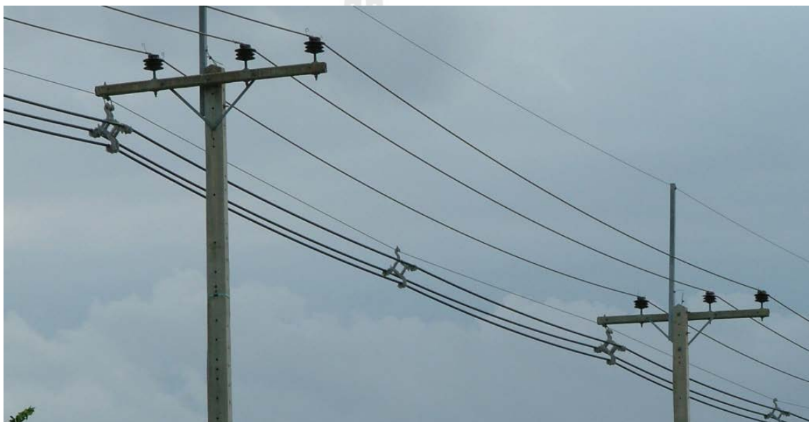
รูปที่ 3.28 การใช้ลูกถ้วยแท่งในระบบจำหน่ายกำลังไฟฟ้า
