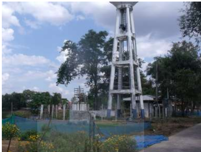
รูปที่ 4.9 ระบบประปาบ้านหนองไฮ หมู่ที่ 9
