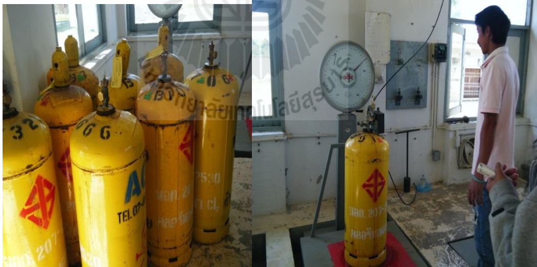
รูปที่ 2.8 การเติมแก๊สคลอรีนก่อนเข้าถังเก็บน้ำใสของการประปาส่วนภูมิภาคปักธงชัย นครราชสีมา
