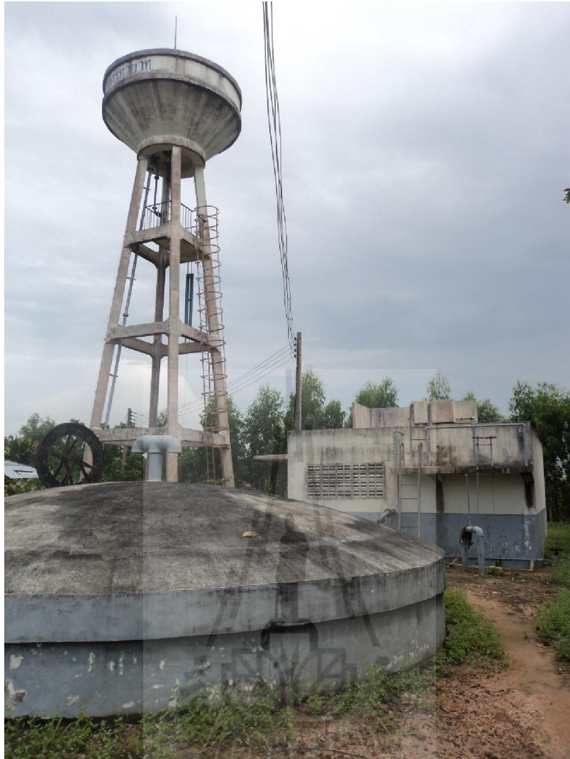
(ค) ตัวอย่างอ่างเก็บน้ำใสและหอถังสูงของระบบประปาผิวดิน
