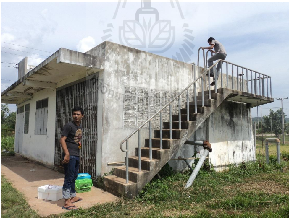
(ข) ตัวอย่างระบบปรับปรุงคุณภาพน้ำของระบบประปาผิวดิน
