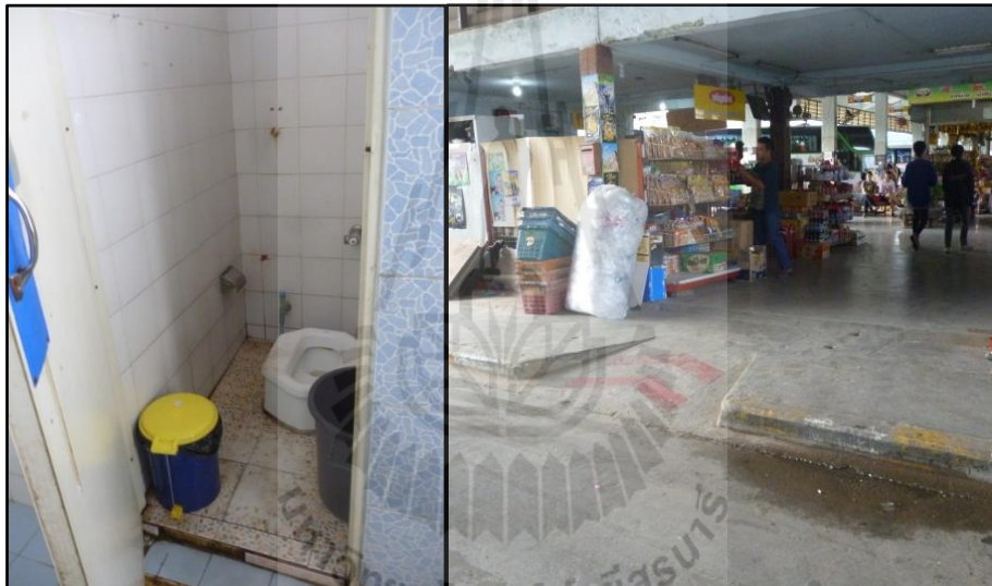
รูปที่ 3.5 ห้องน้ำและทางลาดภายในบริเวณสถานีขนส่งจังหวัดขอนแก่น
