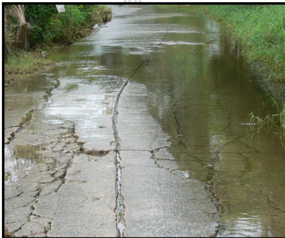
รูปที่ 4.2 ความเสียหายของถนน ค.ส.ล. บ้านมะค่า หมู่ที่ 6
