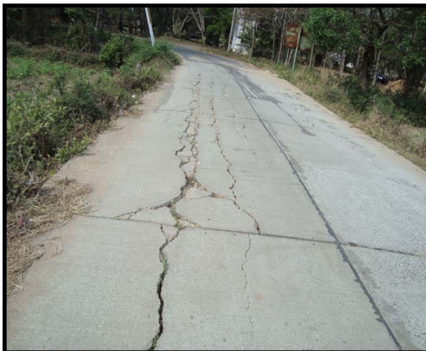
รูปที่ 4.6 ความเสียหายของถนน ค.ส.ล. บ้านวังหิน หมู่ที่ 5 (เส้นที่ 3)
