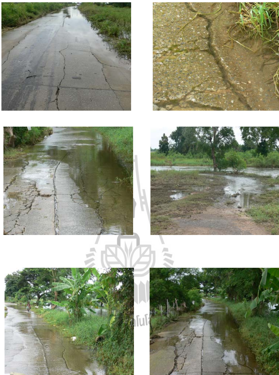
รูปที่ 2.11 ภาพความเสียหายของถนนคอนกรีตเสริมเหล็กที่ชำรุดเนื่องจากอุทกภัย ตำบลบ้านโพธิ์ อำเภอมือง จังหวัดนครราชสีมา
