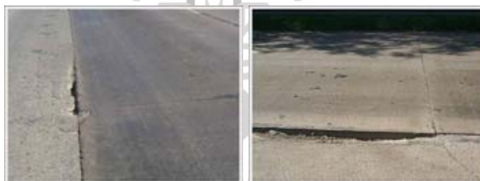
รูปที่ 2.2 ภาพแสดงโพรงขนาดใหญ่ที่รอยต่อระหว่างผิวถนนคอนกรีตกับไหล่ทางลาดยาง
