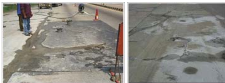
รูปที่ 2.6 การอัดน้ำปูนต่อไปจนเต็มโพรง
