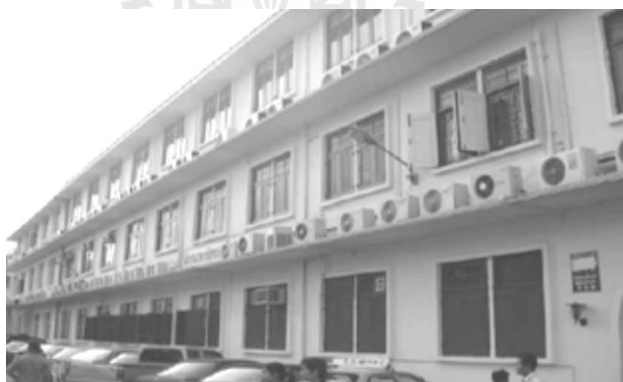
รูปที่ 3.13 ตัวอย่างการวาง ชุดระบายความร้อน ที่ไม่ก่อให้เกิดความเดือดร้อนรำคาญต่อผู้สัญจร
