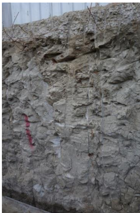
รูปที่ 4.36 เนื้อดินซีเมนต์ที่เกิดจากการขุดลอกออกครั้งต้น
