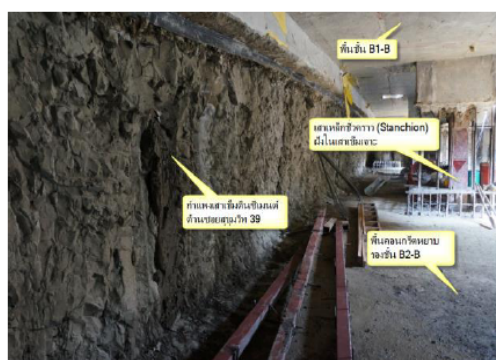
รูปที่ 12 สภาพกำแพงหลังจากเทพื้นคอนกรีตหยาบรองพื้นชั้น B2-B
