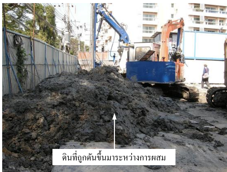
รูปที่ 4.6 ดินที่ถูกดันขึ้นปากหลุมในระหว่างการก่อสร้าง SCC
