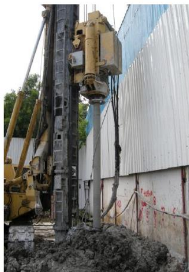
รูปที่ 8 การก่อสร้างเสาเข็มดินซีเมนต์ชนิดแนวรั้วคอนกรีตบล็อกซึ่งวางอยู่บนฐานรากเสาเข็มสั้น
