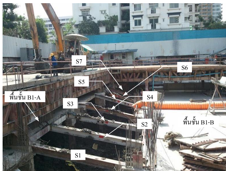
รูปที่ 4.4 ตำแหน่งการติดตั้งค้ำยันชั่วคราวเพื่อถ่ายแรงระหว่างพื้นที่ B1-A กับพื้นที่ B1-B
