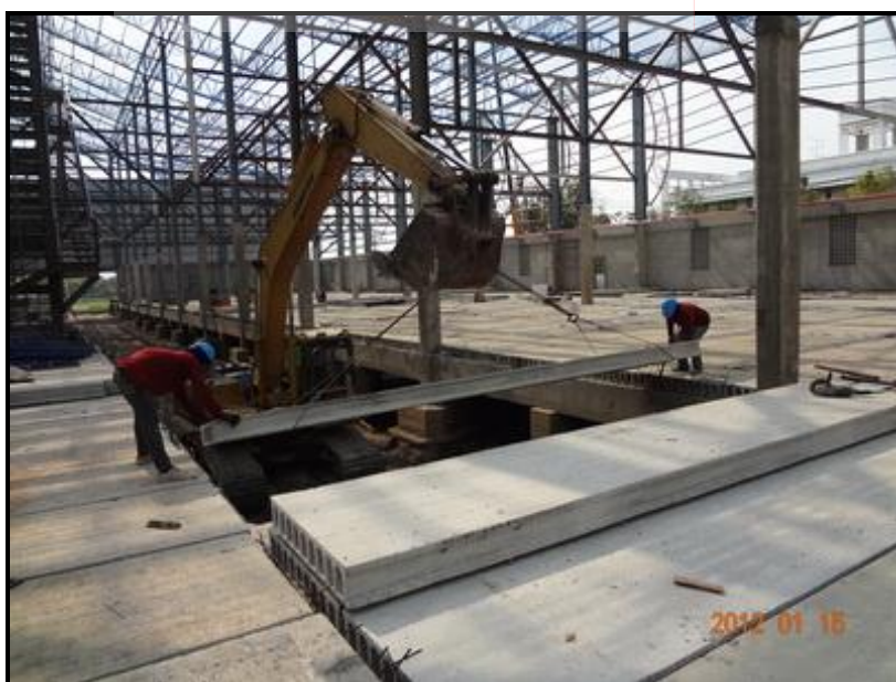
รูปที่ 4.13 การวางแผ่นพื้นสำเร็จโดยใช้รถแบ็คโฮ
