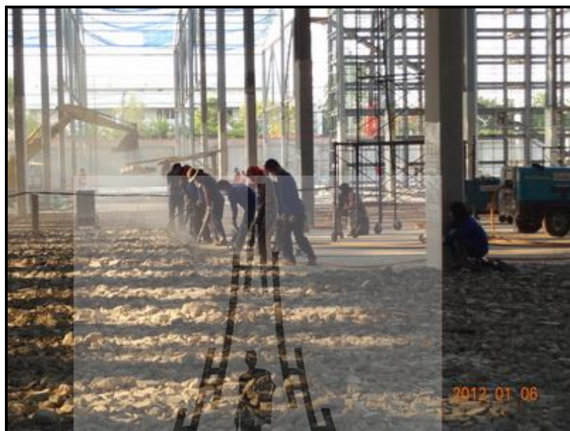
รูปที่ 4.7 สกัดพื้นที่แตกร้าว เพื่อเทคอนกรีตใหม่
