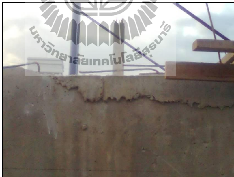
รูปที่ 4.4 สภาพคานคอนกรีตที่เข้าแบบไม่ยึดให้แข็งแรงแล้วเทคอนกรีต
