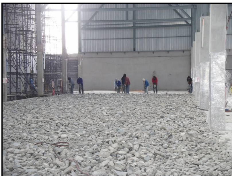
รูปที่ 4.17 สกัดพื้นที่แตกร้าว เพื่อเทคอนกรีตใหม่
