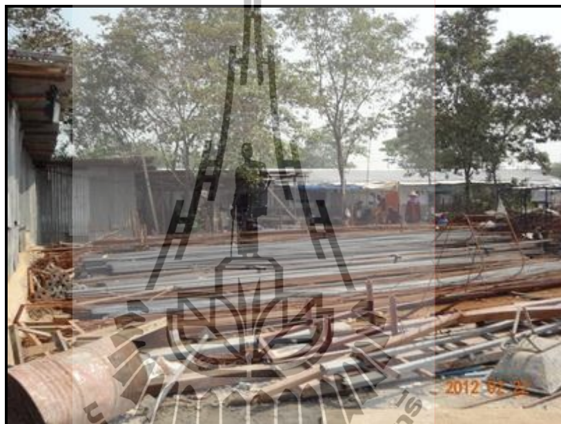
รูปที่ 4.9 การกองเก็บเหล็กเส้นกลมไม่ได้แยกขนาด
