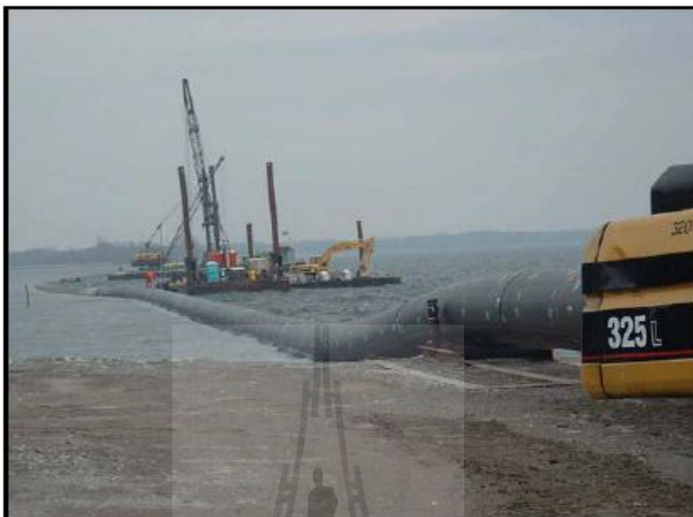
รูปที่ 2.8 ท่อที่ยังไม่ได้วางท่อน้ำหนัก กำลังถูกปล่อยไปยังเรือ Barge เพื่อทำการติดตั้งท่อน้ำหนัก
