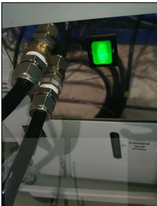
รูปที่ ข. 2 สวิตช์ ON/OFF ระบบน้ำหล่อเย็น
