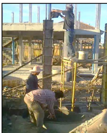
รูปที่ 4.2 ขั้นตอนการทำงานคอนกรีตในแนวดิ่ง
