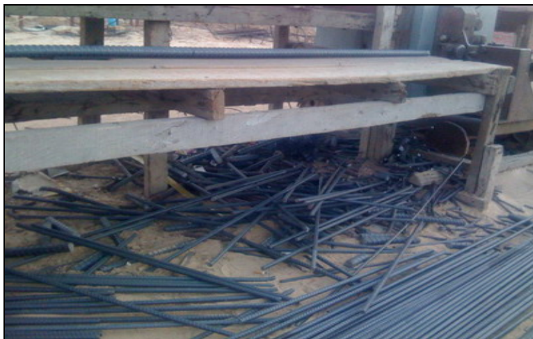
รูปที่ 4.7 เศษเหล็กจำนวนมากที่เกิดจากการตัดเหล็กเส้นของโครงการที่ 2
