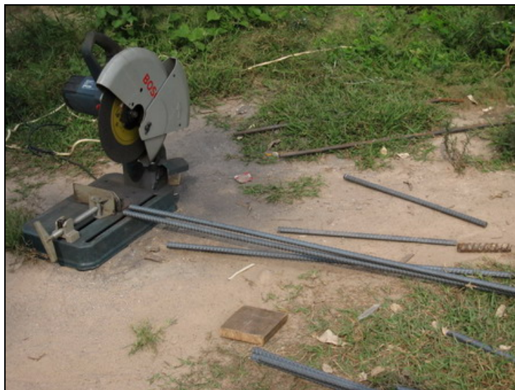
รูปที่ 4.6 การตัดเหล็กเส้นในหน้างานจริงของโครงการก่อสร้างที่ 1
