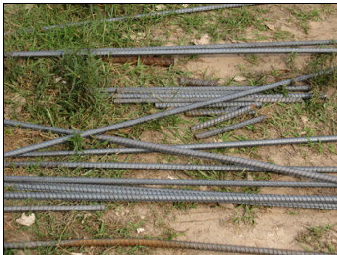
รูปที่ 3.4 เศษเหล็กเส้นที่เกิดจากการตัดที่พบได้ตามโครงการก่อสร้าง
