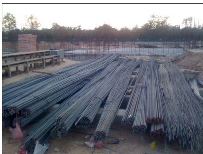
รูปที่ 3.3 เหล็กเส้นที่วางรอการตัด มีการจำหน่ายเป็นขนาดมาตรฐาน
