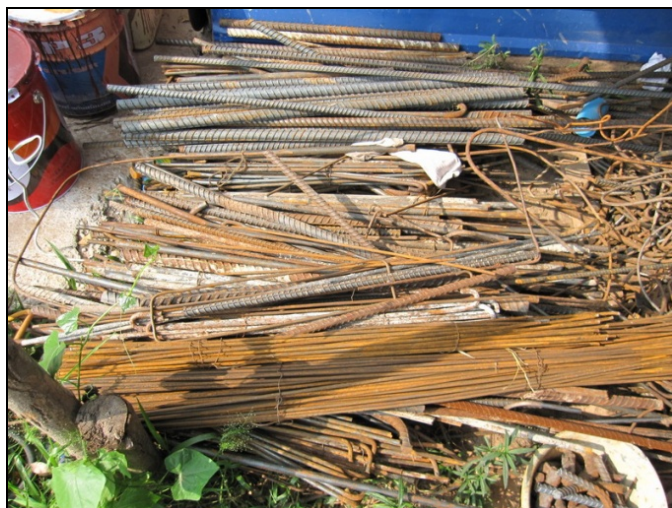
รูปที่ 1.3 เศษเหล็กจำนวนมากที่เกิดจากการตัดเหล็กเส้นที่ไม่เหมาะสม
