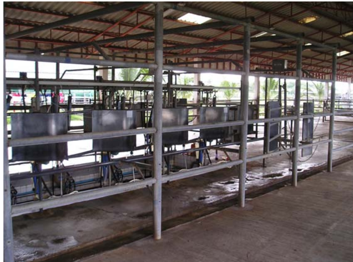
รูป 4.10 ง) แสดงสภาพของระบบขังน้ำนมที่ฟาร์ม มทส. ทำการซื้อมาติดตั้ง
