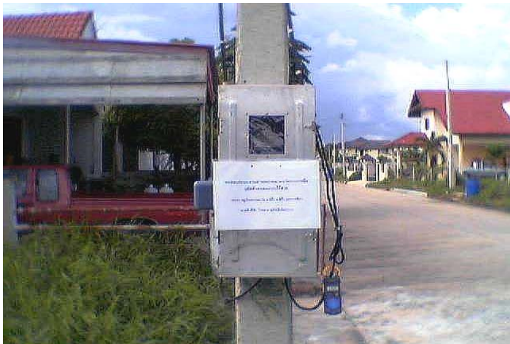
รูปที่ 4.9 การติดตั้งระบบจุดที่หนึ่ง
