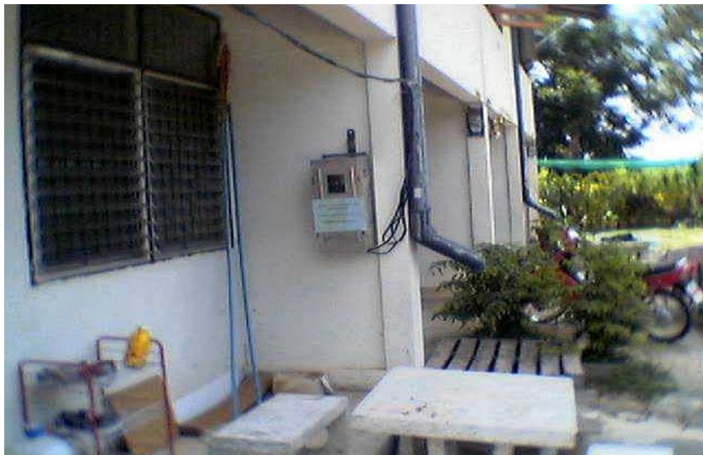
รูปที่ 4.11 การติดตั้งระบบจุดที่สอง
