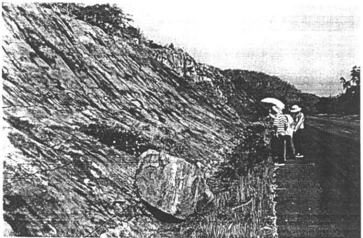
รูปที่ ก-31 ก้อนมวลหินทรายขนาด 0.8 \times 0.7 \times 0.7 \text{ m}^3 กลิ้งตกมาจากส่วนบนของความลาดเอียงมวลหินบริเวณไหล่ทาง (Slope No.12)
