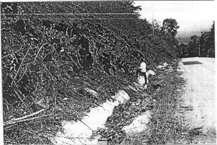
รูปที่ ก-102 เศษหินที่ร่วงหล่นบริเวณฐานของความลาดเอียงมวลหินขนาดประมาณ 0.15 \times 0.2 \times 0.2 ถึงขนาด 0.6 \times 0.5 \times 0.3 \text{ m}^3 (Slope No.35)
