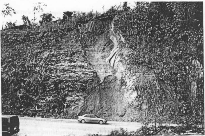
รูปที่ ก-94 การพังทลายแบบแผ่นระนาบ ผสมผสานกับแบบ ไหลโค้งของชั้นดินที่วางกคทับ อยู่บริเวณด้านบน (Slope No.33)
