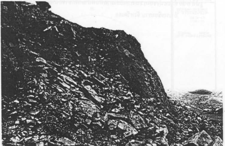
รูปที่ ก-52 ลักษณะของมวลหินกึ่งดินดานในบริเวณ Footwall ของเหมืองแร่ Barite อำเภอเชียงคาน จังหวัดเลย (Slope Nos. 18-23)
