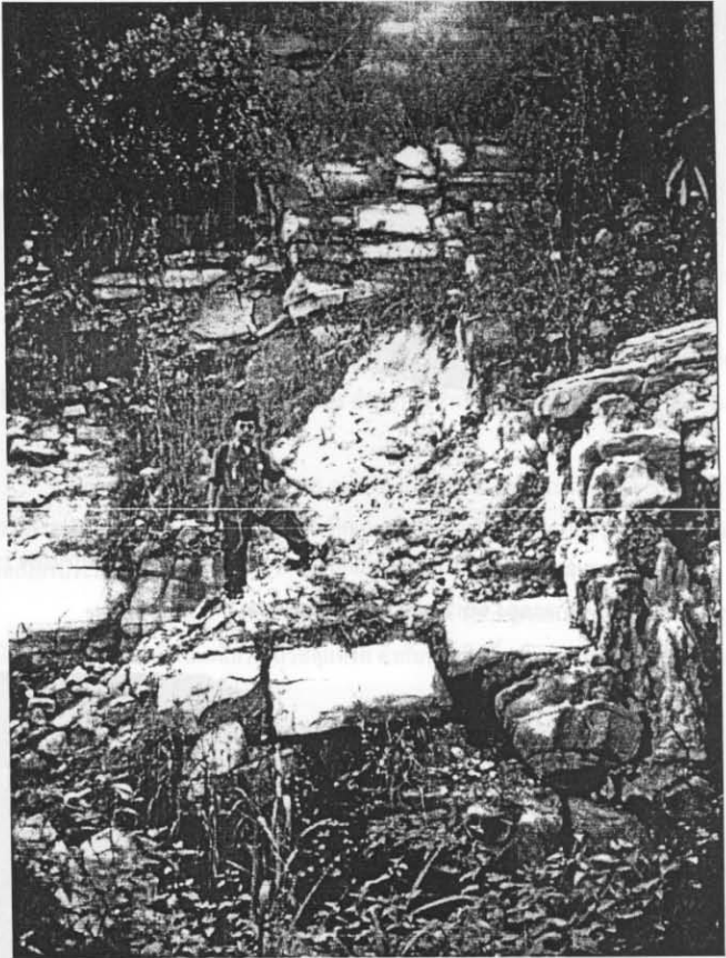
รูปที่ ก-37 ลักษณะของการพังทลายที่ปรากฏของความลาดเอียงมวลหินแบบแข็งสลับอ่อน (Slope No.14)
