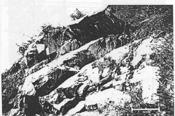
รูปที่ ก-41 ความลาดเอียงมวลหินบริเวณหลักกิโลเมตรที่ 136-137 ของทางหลวงหมายเลข 2 บริเวณอำเภออมก๋อยเหล็ก จังหวัด สระบุรี (Slope No.15)
