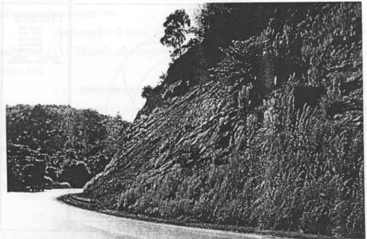
รูปที่ ก-80 การพังทลายแบบ Circular ที่เกิดบริเวณผิวหน้าของความลาดเอียงมวลหิน แบบมีค่ากำลังรับแรงอัดต่ำ (Slope No.28)
