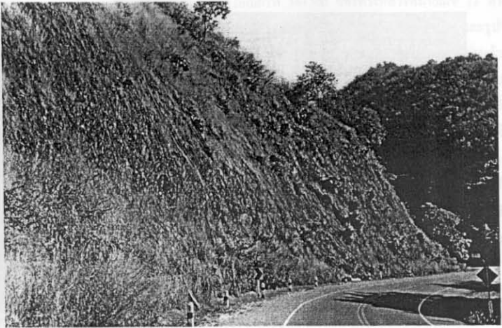
รูปที่ ก-91 ความลาดเอียงมวลหินบริเวณหลักกิโลเมตรที่ 18-19 ของเส้นทางหลวงหมายเลข 12 ชุมแพ หล่มสัก (Slope No.32)
