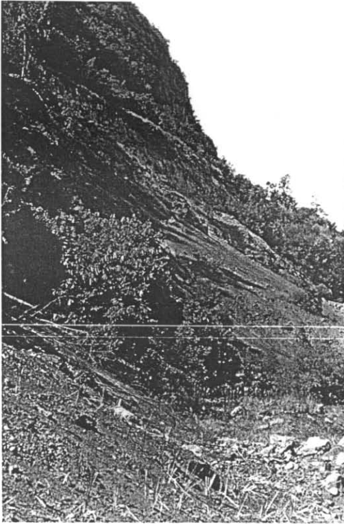
รูปที่ ก-9 ด้านข้างของหน้าความลาดเอียงที่เกิดจากการขุดเอาส่วนที่เป็นหินดินดานที่บริเวณฐานของเขาเจ้าลาขใหญ่ (Slope No.2)
