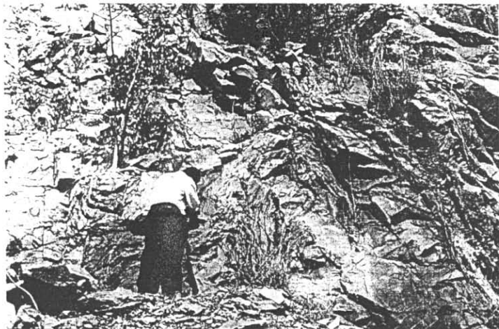
รูปที่ ก-27 ลักษณะรอยแตกของมวลหินปูนที่อยู่บริเวณเหมืองหิน ซึ่งเกิดจากธรรมชาติและ จากแรงระเบิด (Slope No.11)
