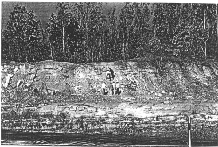
รูปที่ ก-13 การพังทลายแบบ Secondary toppling ของความลาดเอียงแบบแข็งสลับอลันในบริเวณหลักกิโลเมตรที่ 70 ของเส้นทางหลวงหมายเลข 304 (Slope No.3)
