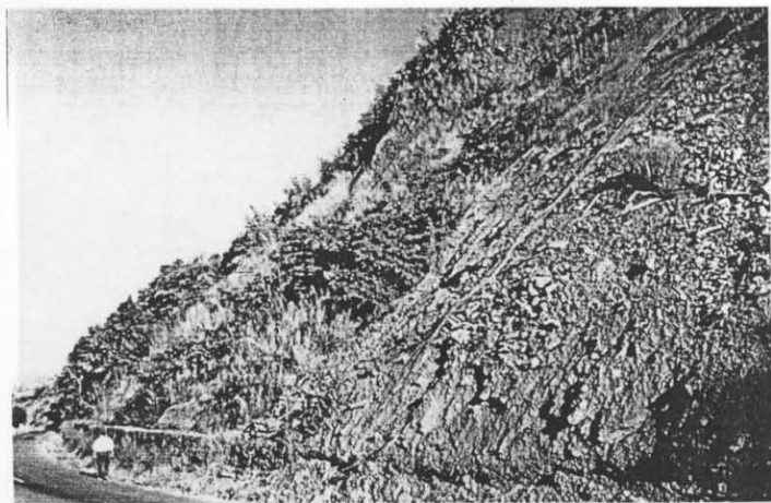
รูปที่ ก-88 บางส่วนของความลาดเอียงมวลหินที่เกิดการพังทลาย (Slope No.30)
