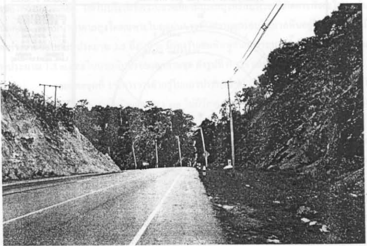
รูปที่ ก-121 ความลาดเอียงมวลหินดินดานด้านทิศเหนือและใต้ และระยะปลอดภัยของขอบถนนที่ห่างจากฐานของความลาดเอียง (Slope No.41)
