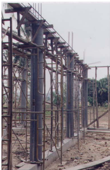
รูปที่ 1.1 การก่อสร้างเสาคอนกรีตเสริมเหล็กที่ถูกห่อหุ้มด้วยท่อซีเมนต์ไยหิน
