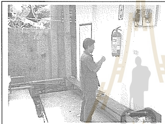
ภาพที่ 19 แสดงการทำการตรวจสอบถังดับเพลิง
