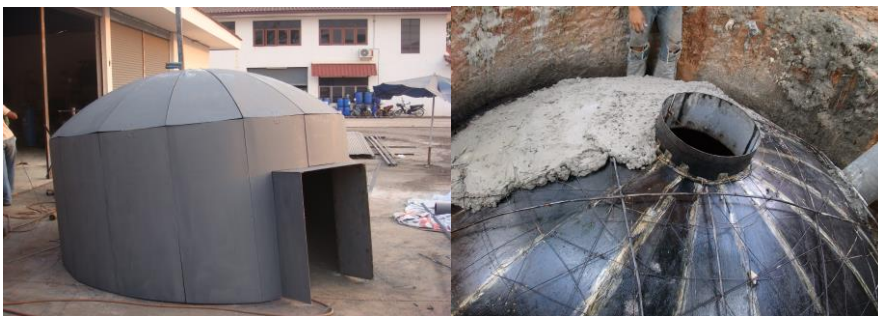
การก่อสร้างบ่อแก๊สชีวภาพจากแบบถาวร
