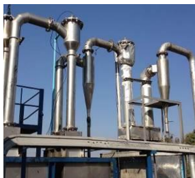
ระบบทำความสะอาดแก๊ส เชื้อเพลิง (สครับเบอร์)
