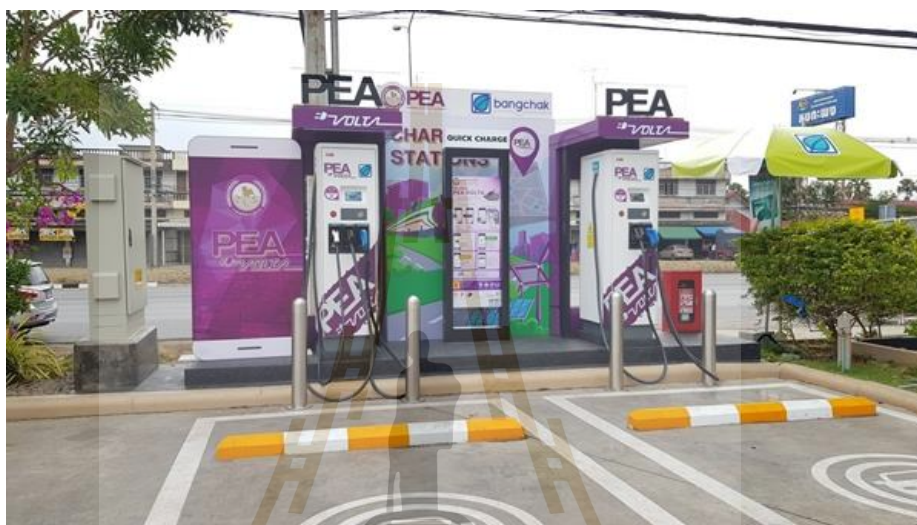
รูปที่ 3.15 สถานีอัดประจุไฟฟ้าที่ใช้พลังงานไฟฟ้าจากระบบโครงข่ายไฟฟ้าติดตั้งที่ปั้มบางจากสาขาชะอำปาร์ค จังหวัดเพชรบุรี ที่มาภาพ: https://mgronline.com/local/detail [เข้าถึงเมื่อ 21 ก.พ. 2567]
