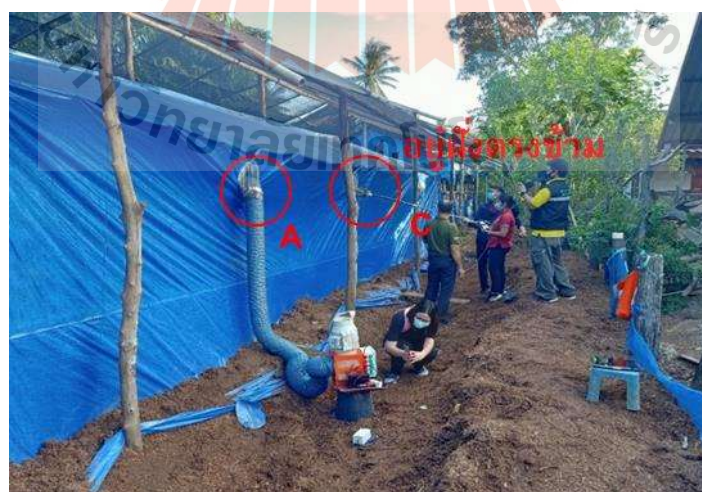
รูปที่ 3.22 การติดตั้งชุดชุดระบายอากาศและตรวจสอบสภาพอากาศในที่อับอากาศแบบเคลื่อนที่ที่พัฒนาขึ้นเข้ากับโรงเพาะเห็ดฟาง
