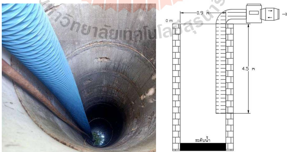
รูปที่ 3.28 การติดตั้งอุปกรณ์ทดสอบที่ระดับความลึก 4.50 เมตร ในบ่อบาดาล
