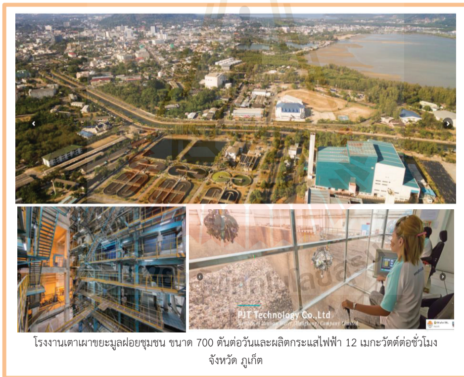
ภาพที่ 3.2 เตาเผาขยะมูลฝอยเพื่อผลิตกระแสไฟฟ้า จังหวัดภูเก็ต (ที่มา : PJT Technology Co.,Ltd – บริษัท พีเจที เทคโนโลยี จำกัด)
