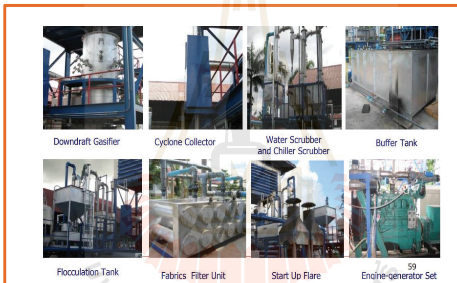
ภาพที่ 3.5 โรงไฟฟ้าเทคโนโลยีแก๊สซิฟิเคชัน ศูนย์ความเป็นเลิศทางด้านชีววมล มหาวิทยาลัยเทคโนโลยีสุรนารี (ที่มา : ศูนย์ความเป็นเลิศทางด้านชีววมล มหาวิทยาลัยเทคโนโลยีสุรนารี)
