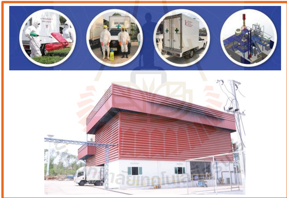
ภาพที่ 3.9 โรงจัดการขยะติดเชื้อและขยะมูลฝอยเหลือทิ้งโดยใช้เทคโนโลยีพลาสมาอาร์ค ศูนย์ความเป็นเลิศทางด้านชีวมวล มหาวิทยาลัยเทคโนโลยีสุรนารี (ที่มา : ศูนย์ความเป็นเลิศทางด้านชีวมวล มหาวิทยาลัยเทคโนโลยีสุรนารี)
