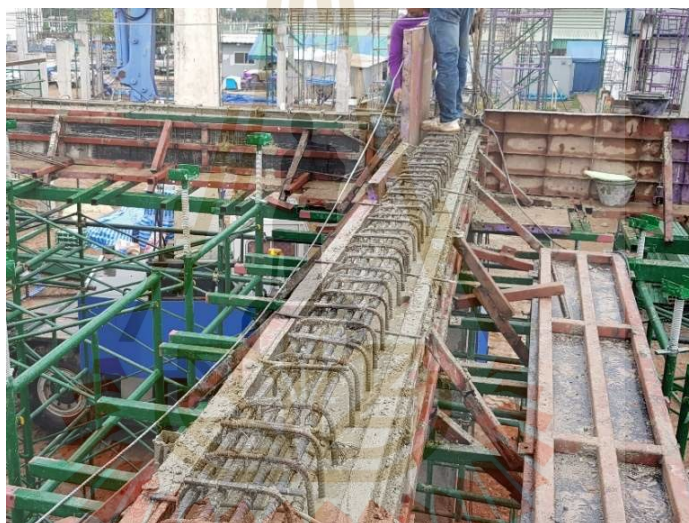
รูปที่ 1.1 การก่อสร้างคานคอนกรีตเสริมเหล็กแบบหล่อในที่
