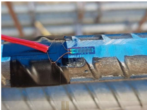
รูปที่ 3.8 การติดตั้ง strain gauge เข้ากับเหล็กเสริม
