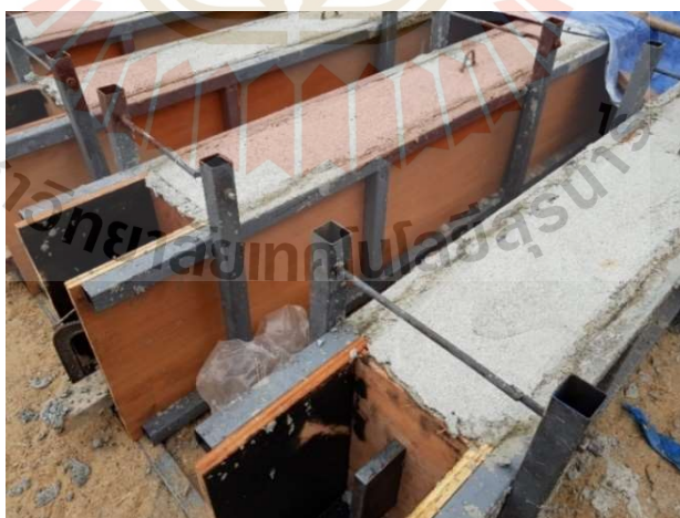
รูปที่ 3.13 คอนกรีตที่หล่อทิ้งไว้ประมาณ 24 ชั่วโมง
