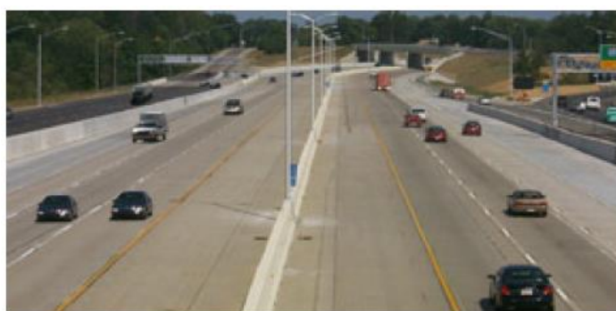
รูปที่ 2.13 สภาพจราจรของระดับการให้บริการ B (สุรเมศวร์ พิริยะวัฒน์, 2551)
