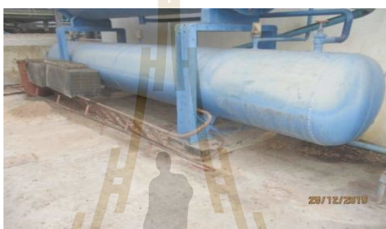
รูปที่ 3.22 ถังเก็บสารทำความเย็น (Refrigerant Receiver)
