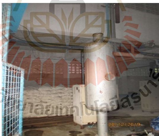
รูปที่ 3.19 เครื่องแยกน้ำมันหล่อลื่น (Oil Separator)
