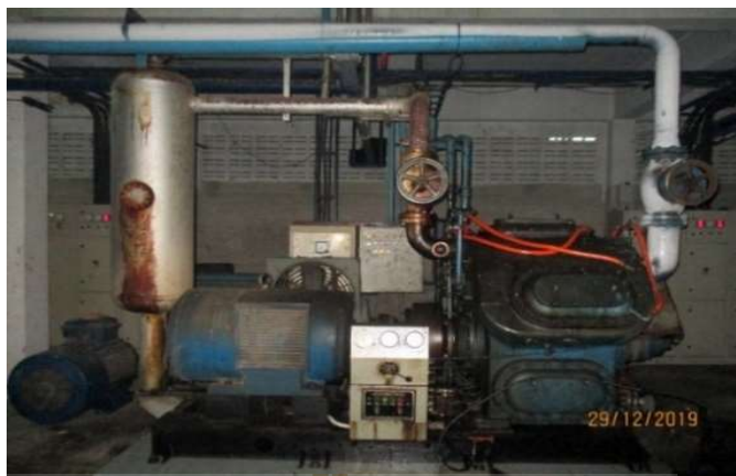
รูปที่ 3.18 คอมเพรสเซอร์ (Compressor)
