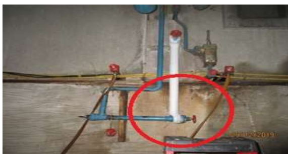
รูปที่ 3.23 วาล์วลดความดัน (Expansion Valve)
