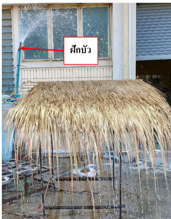
รูปที่ 3.23 การทดสอบการรั่วซึมของน้ำฝน
