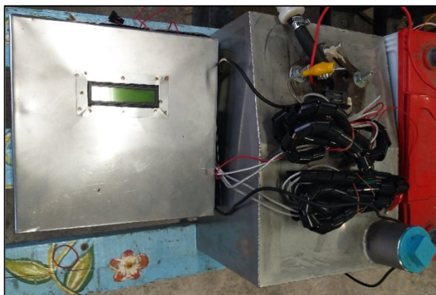
รูปที่ 3.18 ติดตั้งชุดควบคุมการฉีด
