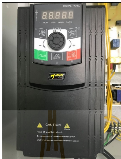
รูปที่ 3.19 อินเวอร์เตอร์สำหรับควบคุมมอเตอร์
