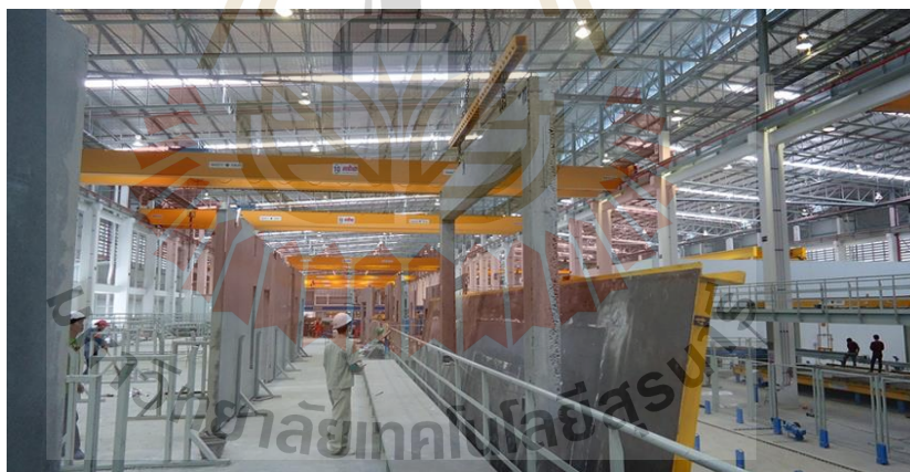
รูปที่ 2.17 การยกชิ้นงาน ( Pruksa Real Estate , 2015)
