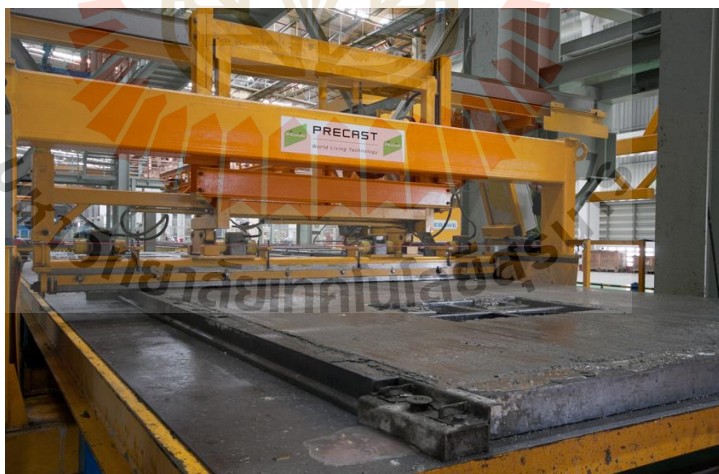
รูปที่ 2.13 การปาดหน้าคอนกรีต( Pruksa Real Estate , 2015)
