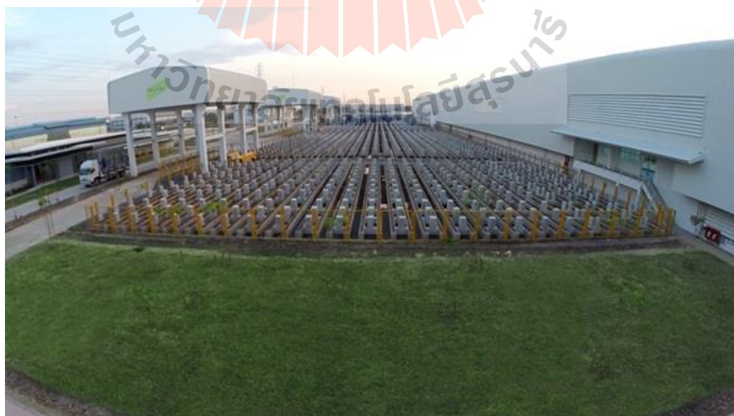
รูปที่ 2.7 โรงงานพุกษา 프리คาสท์ (Pruksa Precast Concrete Factor)
