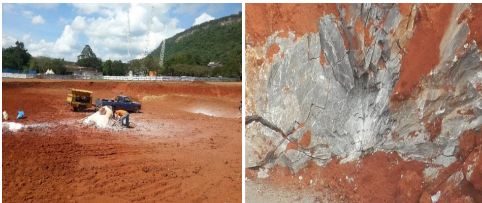
รูปที่ 4.12 การขุดดินพื้นที่ก่อสร้างสระสวนน้ำขนาดใหญ่ ซึ่งมีหินขนาดใหญ่เต็มพื้นที่
