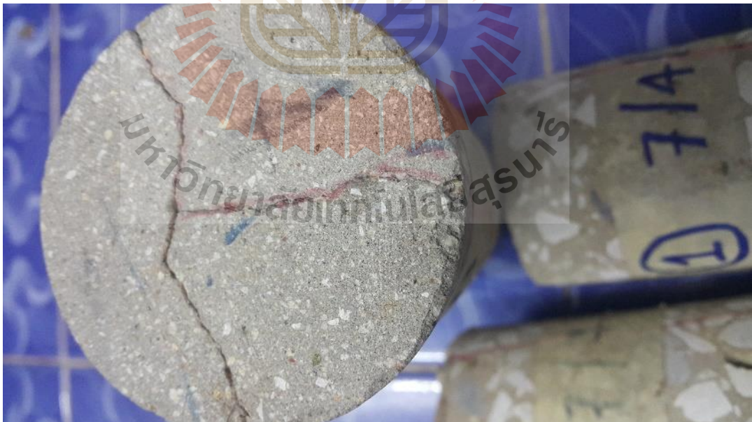
รูปที่ ก.7 ลักษณะการเจาะสำรวจรอยแตกร้าว
