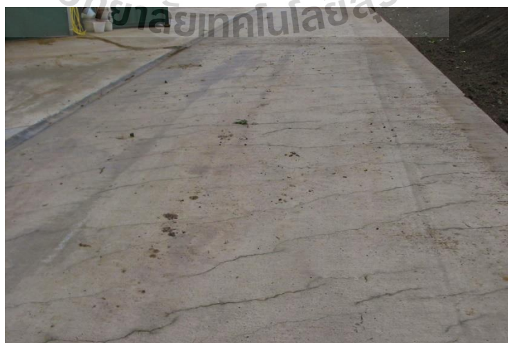
รูปที่ 2.8 การแตกร้าวจากการหดตัวแบบพลาสติก
