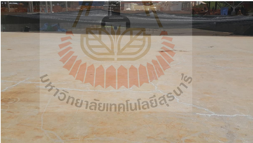
รูปที่ ก.10 รอยแตกร้าวที่ทำการซ่อมแซม และการหาวัสดุกรองแสงเพื่อลดอุณหภูมิ
