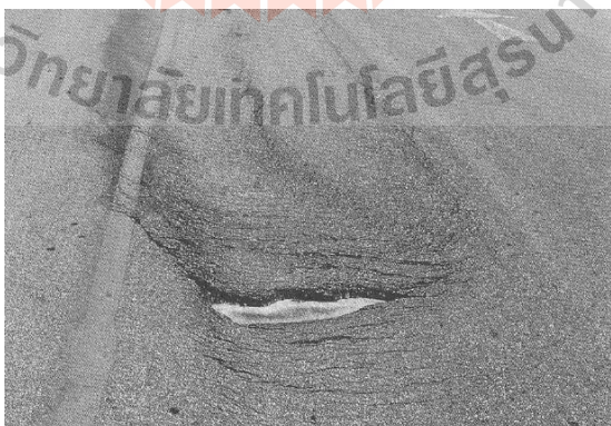
รูปที่ 2.4 รอยแตกเลื่อนไถล (กรมทางหลวง, 2553)
