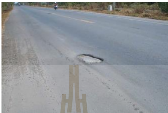
รูปที่ 2.10 หลุมบ่อ (กรมทางหลวง, 2553)
