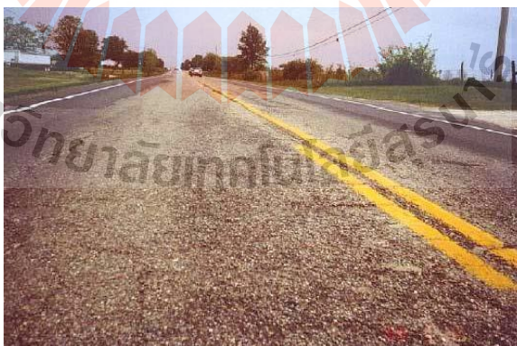
รูปที่ 2.9 การหลุดร่อน (กรมทางหลวง, 2553)
