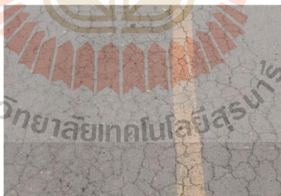
รูปที่ 2.2 รอยแตกหนังจระเข้ (กรมทางหลวง, 2553)
