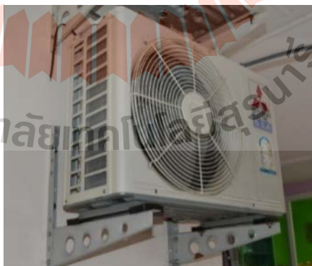
รูปที่ 3.1 ลักษณะการทำงาน of ขาโครงตั้งชุดคอยล์ร้อน
