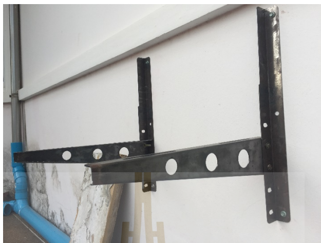
รูปที่ 3.24 การติดตั้งชั้นงาน
