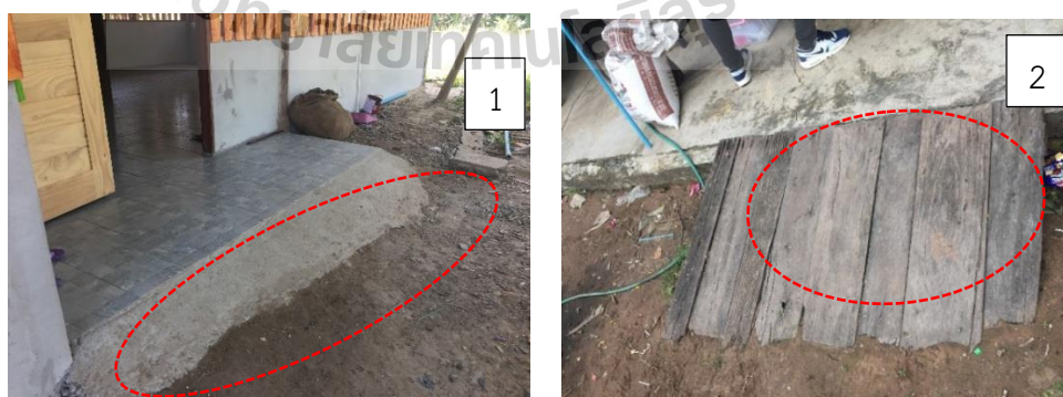
รูปที่ 4.3 ลักษณะทางลาดที่พบบริเวณที่อยู่อาศัยของผู้ใช้รถเข็นนั่ง
