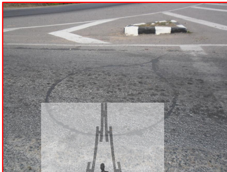
รูปที่ 4.11 ลูปเหนี่ยวนำ (Loop Detector)
